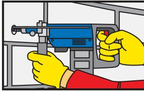
1. Perfore un orificio con un taladro eléctrico del diámetro y la profundidad requeridos. El diámetro del orificio de perforación debe estar de acuerdo con el tamaño del anclaje
